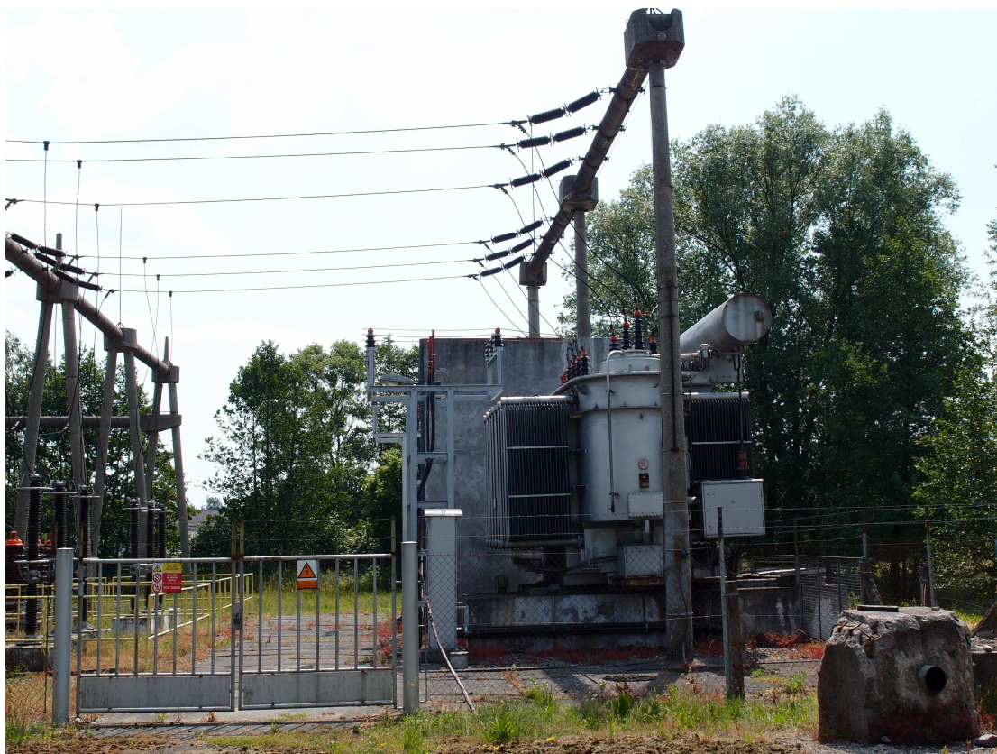
Obr. 1 Převěsy mezi rozvodnou 110 kV a stanovišti transformátorů 110/23 kV s ocelovou konstrukcí pro kabely 22 kV TNS Týniště n/O.
