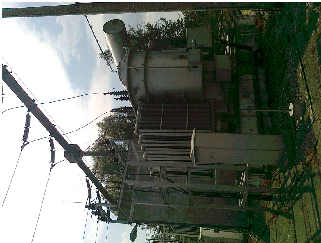
Obr.3 Transformátory T101 - 110/23 kV TNS Týniště n/O s připojením převěsů na průchodky 110 kV, ocelová konstrukce s pasovým vedením na podpěrkách 22 kV pro kabely 22 kV, ovládací skříň transformátoru a svorkovnicová skříň a skříň pro regulaci napětí umístěné na nádobě transformátoru
