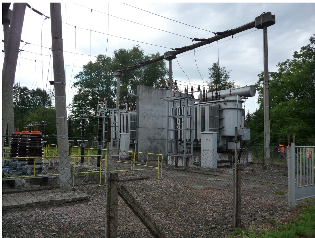
Obr. 1 Převěsy mezi rozvodnou 110 kV a stanovišti transformátorů 110/23 kV s ocelovou konstrukcí pro kabely 22 kV TNS Týniště n/O.
